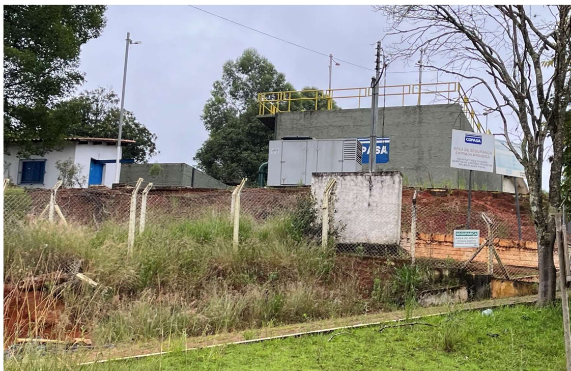
Fonte: Visita Técnica – 1 e 2 na ETA.
