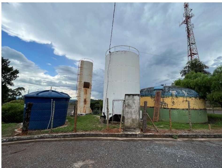
Reservatórios do Santuário - Fonte: Visita Técnica
