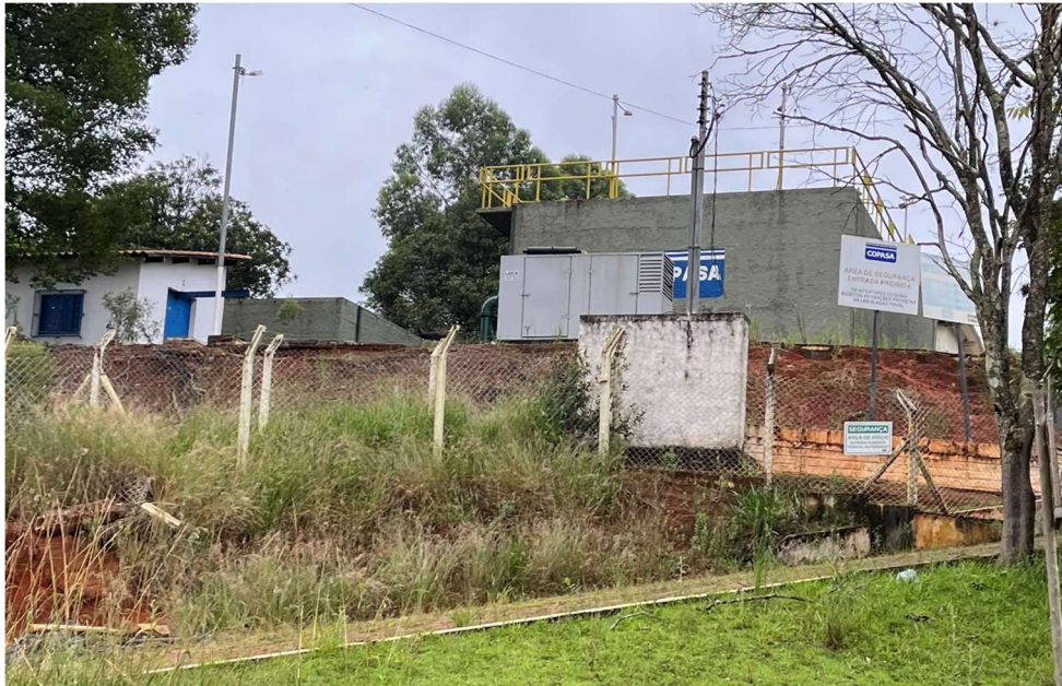
Fonte: Visita Técnica – 1 e 2 na ETA.
