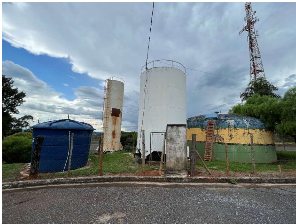
Reservatórios do Santuário - Fonte: Visita Técnica
