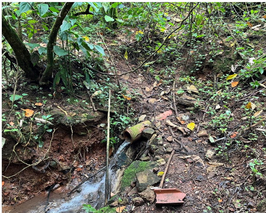
Lançamento de Esgoto – Fonte: Visita Técnica
