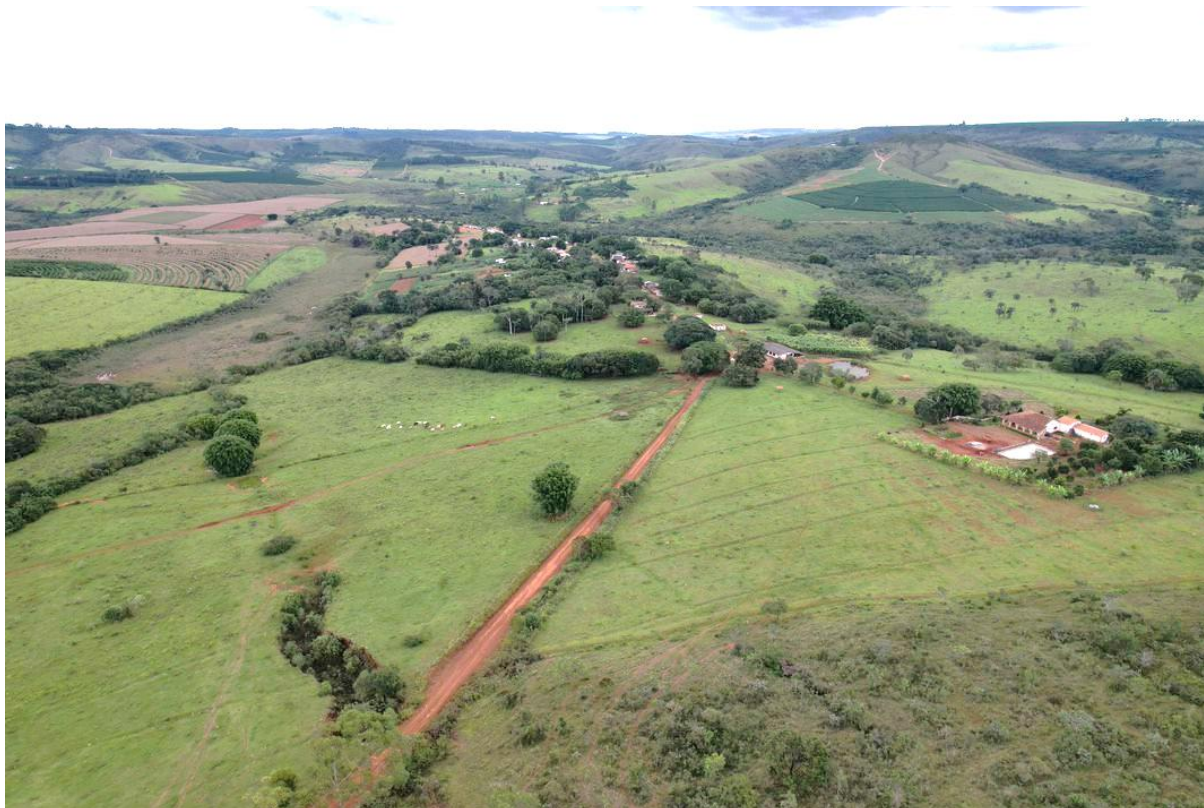
Figura 27 – Vista aérea da estrada que dá acesso à captação
