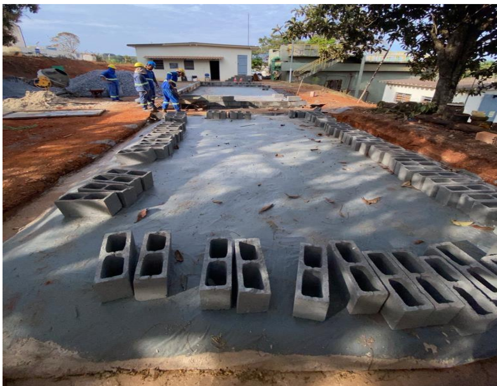
Figura 89 – Construção da UTR
