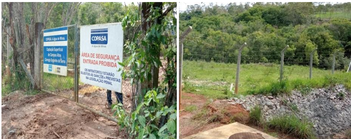
Figura 31 – Placas de identificação e advertência, e cercamento da unidade
