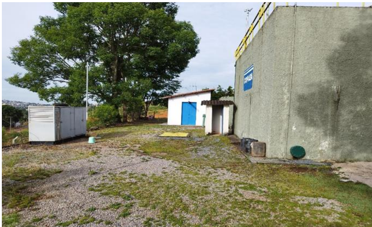
Figura 109 – Área interna da ETA
