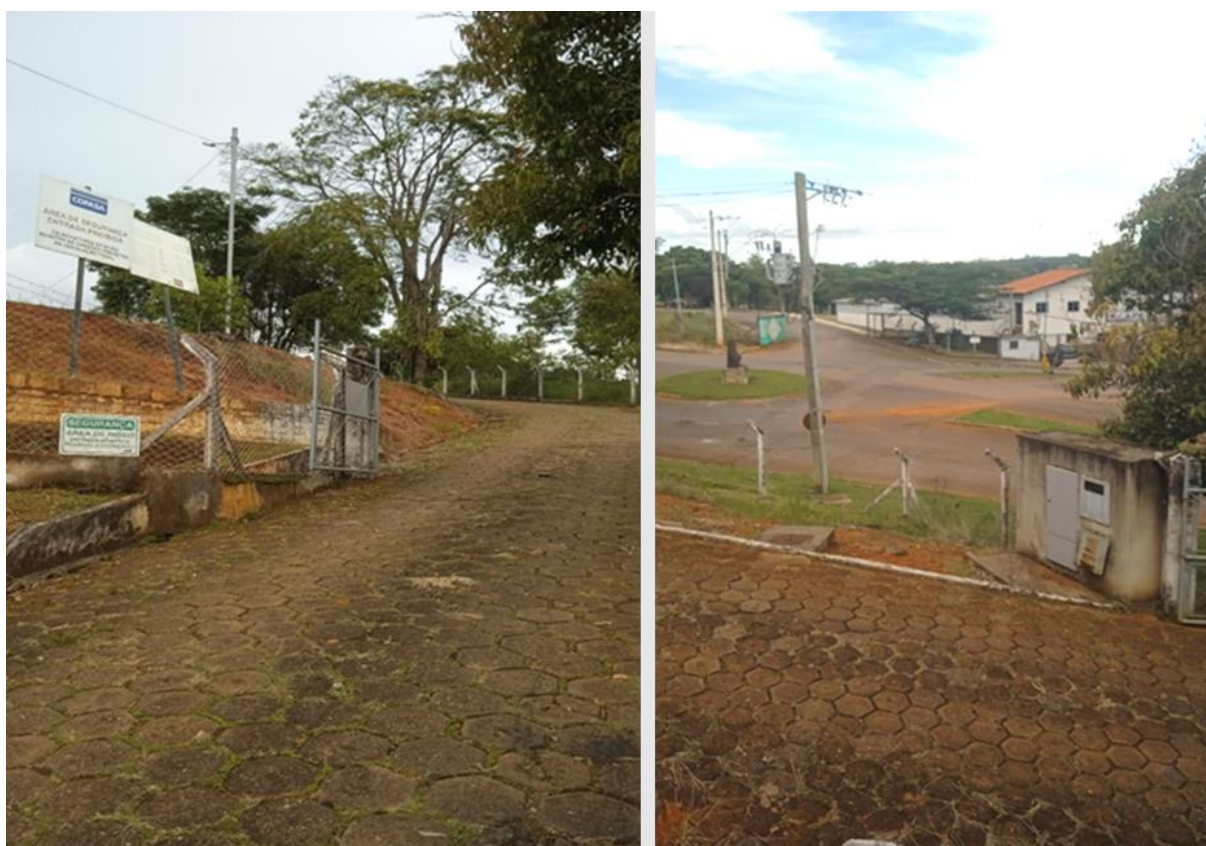
Figura 107 – Placas de identificação e segurança, cercamento da unidade
