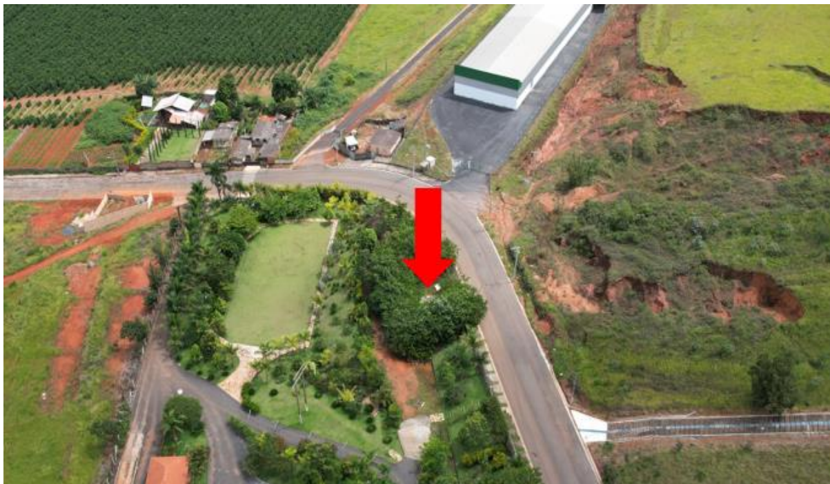
Figura 132– Localização do RAP04, indicado pela seta, e entorno
