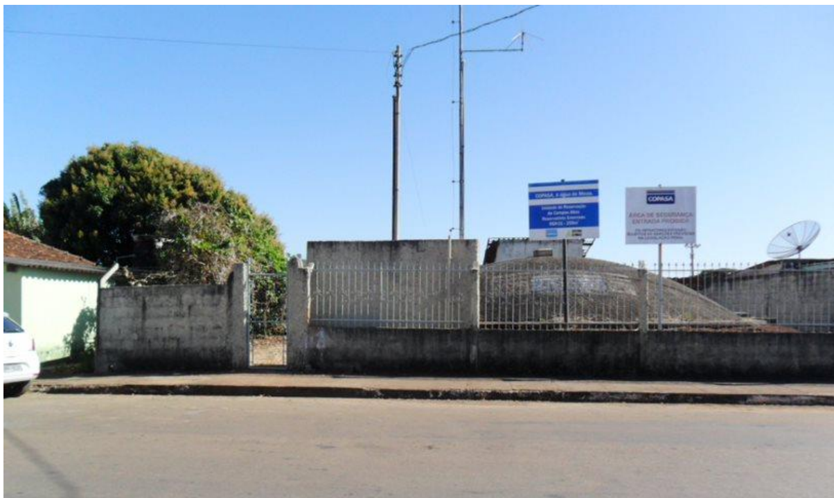
Figura 141 – Cercamento da unidade, placas de identificação e advertência
