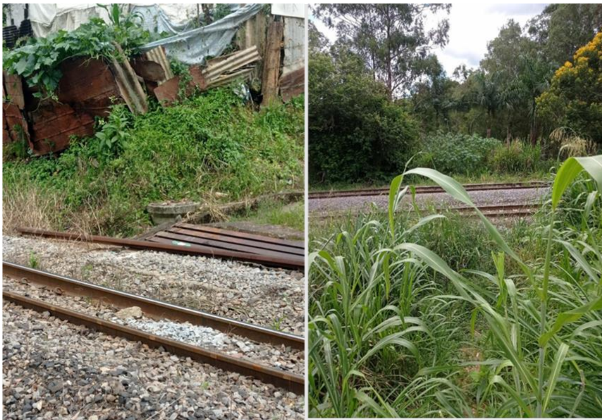
Figura 199 – Travessias de rede coletora de esgoto sob linha férrea
