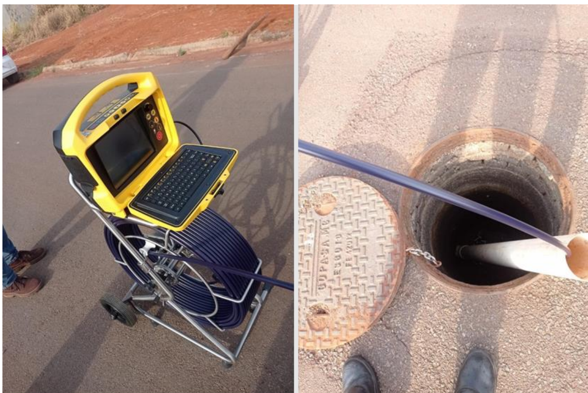
Figura 204 – Filmagens de rede de esgoto
