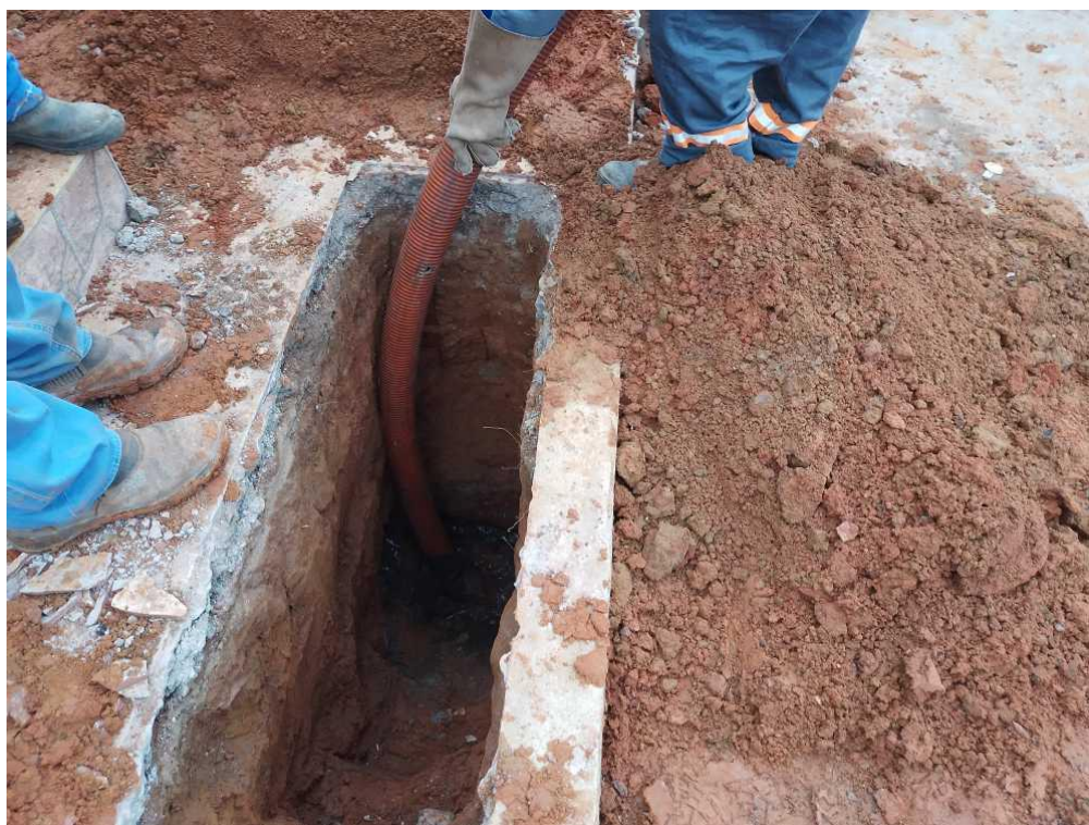
Figura 201 – Limpeza, desobstrução e sucção de esgoto com caminhão hidrojato
