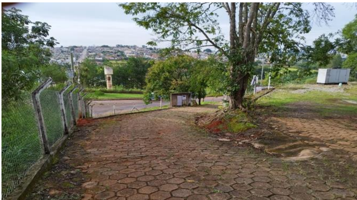
Figura 108 – Acesso a ETA
