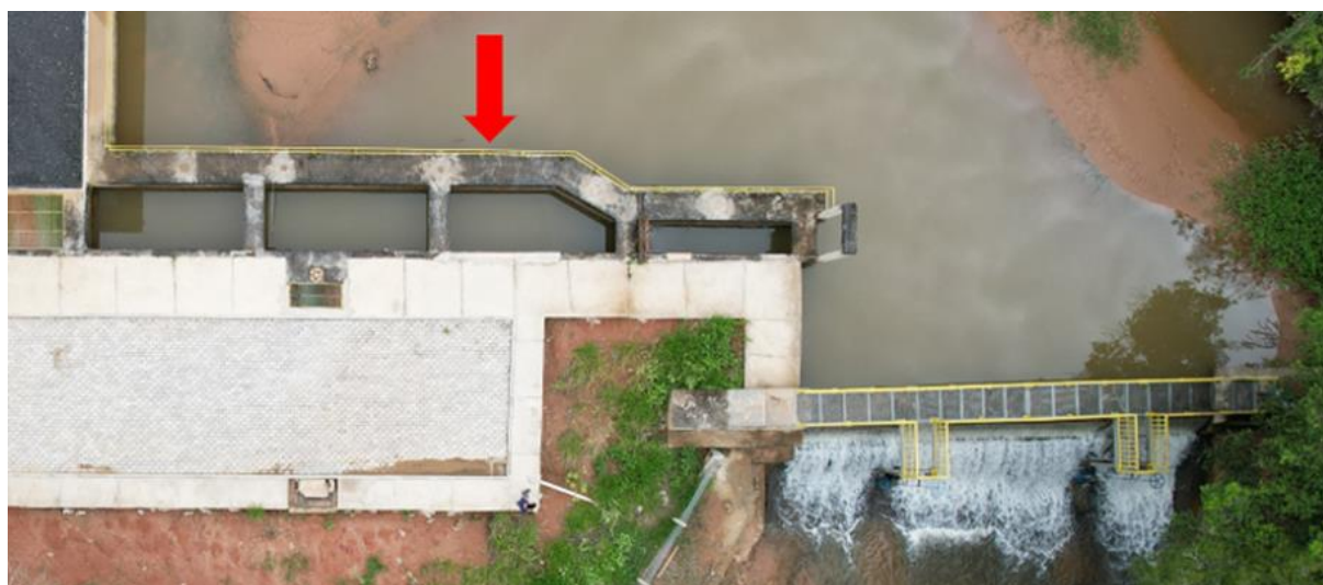
Figura 36 – Vista aérea de um modelo de desarenador
