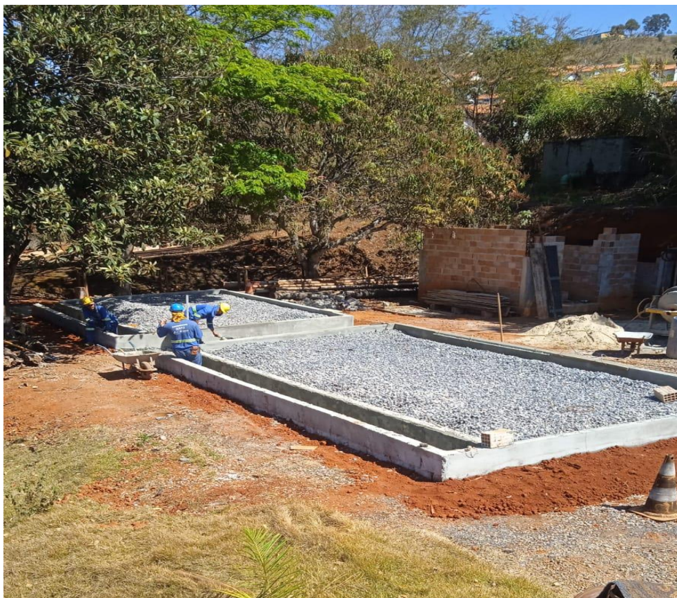
Figura 90 – Construção da UTR
