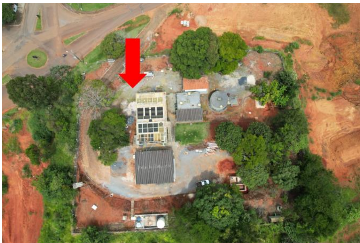
Figura 87 – Localização da implantação da UTR e entorno
