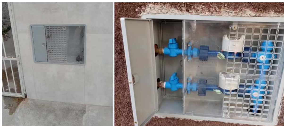
Figura 181 – Exemplos de ligações prediais padrão
