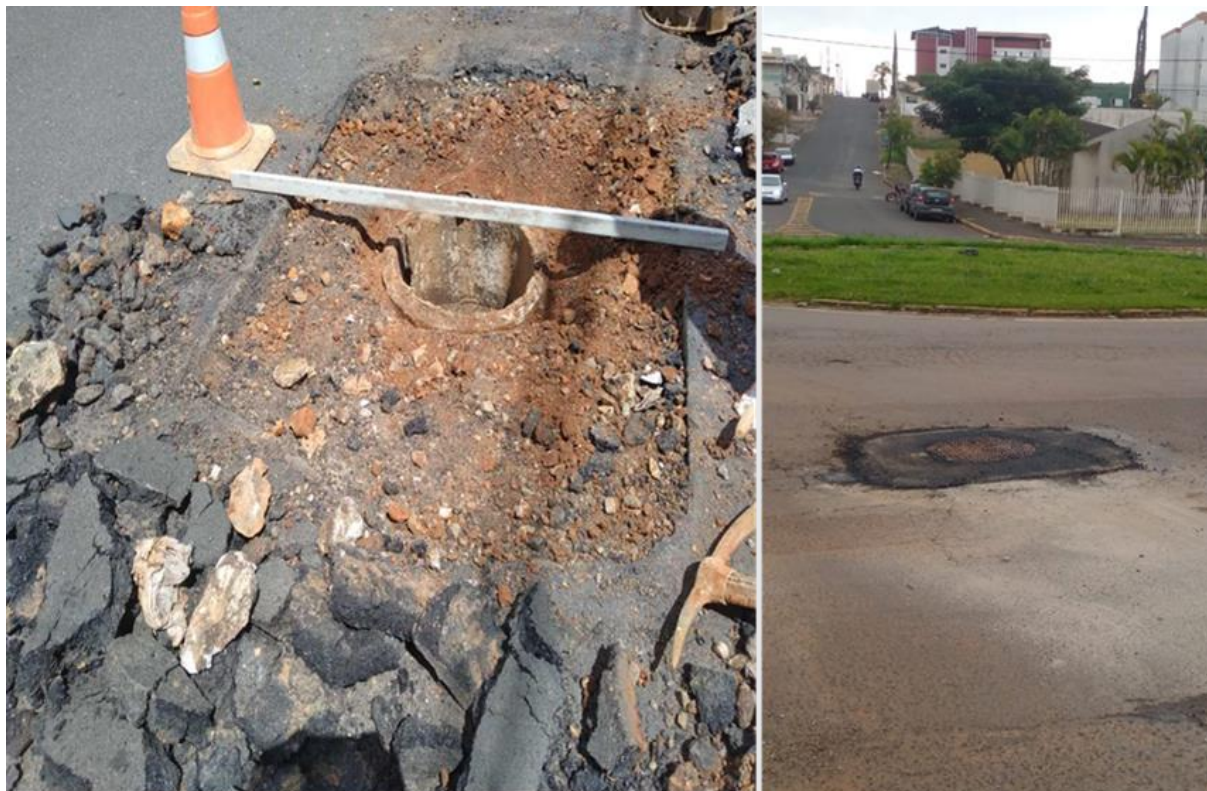
Figura 203 – Serviço de alteamento de PV antes e após execução
