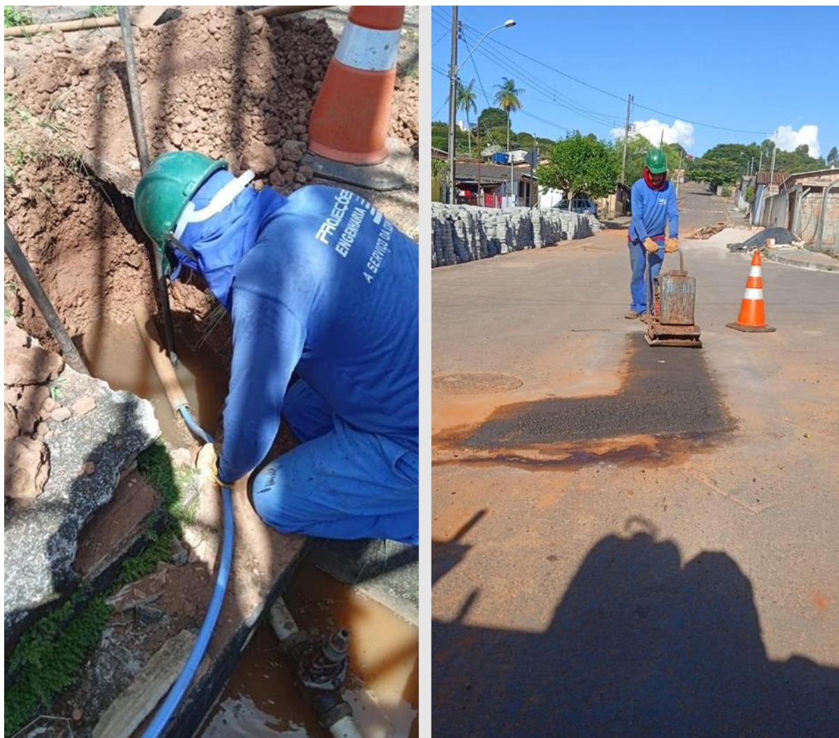
Figura 171 – Serviço de manutenção em rede de água e recomposição de pavimento
