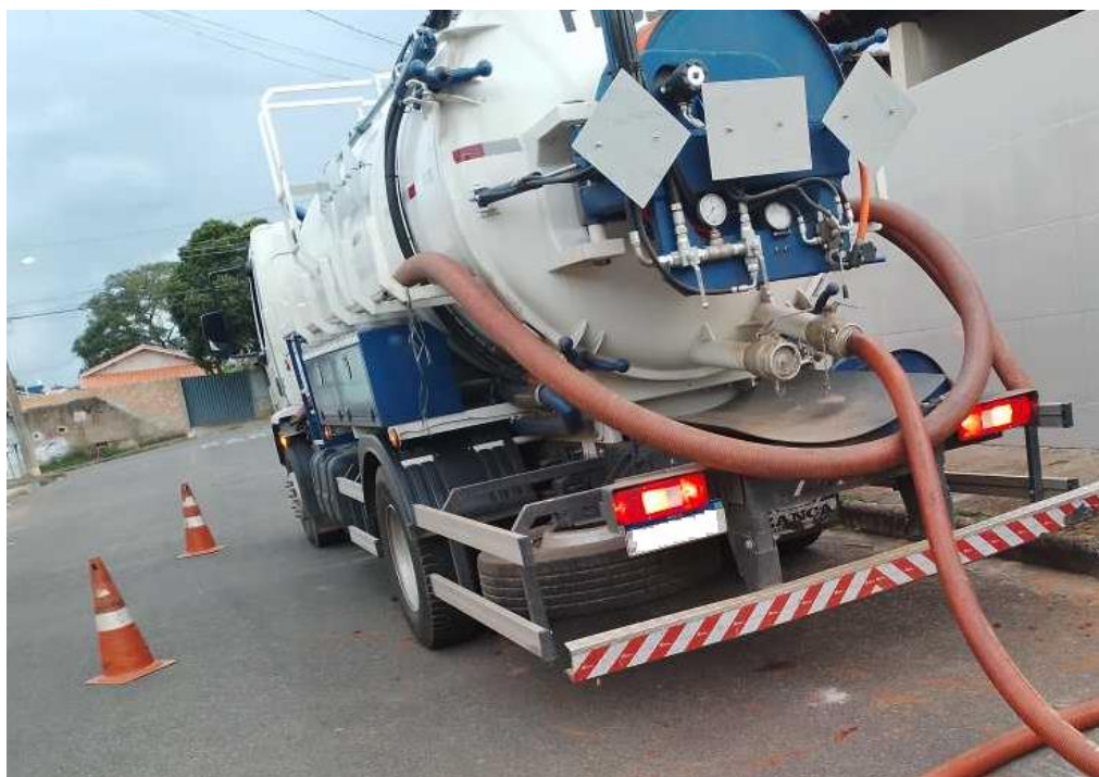
Figura 202 – Limpeza, desobstrução e sucção de esgoto com caminhão hidrojato
