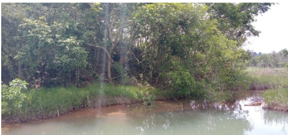
Figura 46 – Barragem do Córrego Engenho da Serra assoreada
