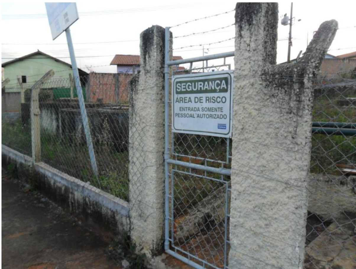
Figura 147– Cercamento da unidade e placa de advertência
