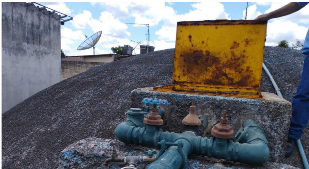
Figura 97 – Vista externa da EPS01
