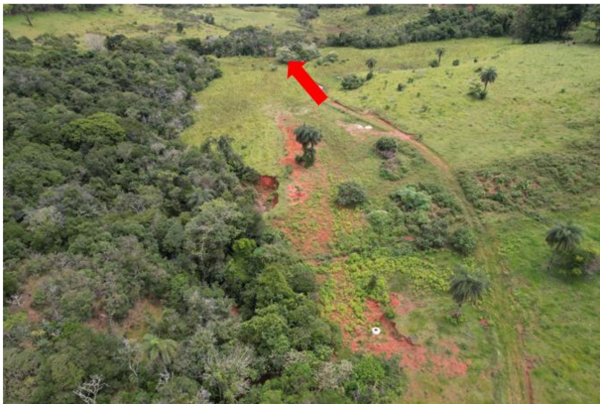
Figura 21 – Acesso a captação córrego Engenho da Serra. Captação em destaque
