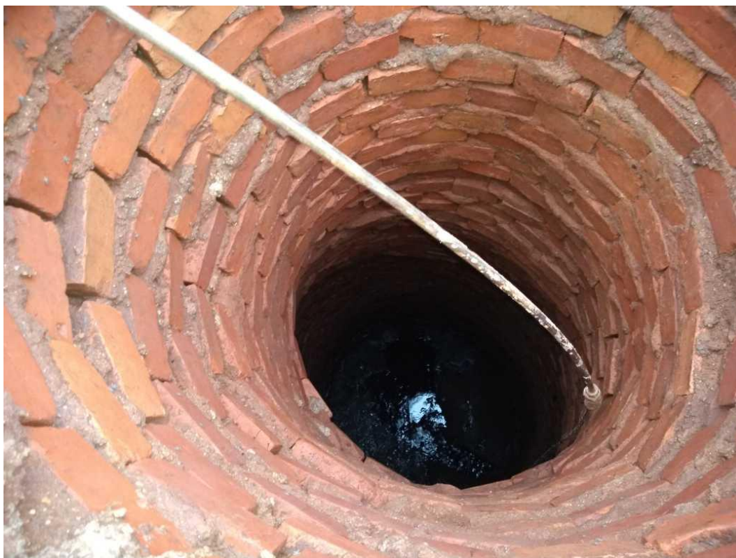
Figura 200 – Desentupimento de tubulações com arame com acesso pelo PV
