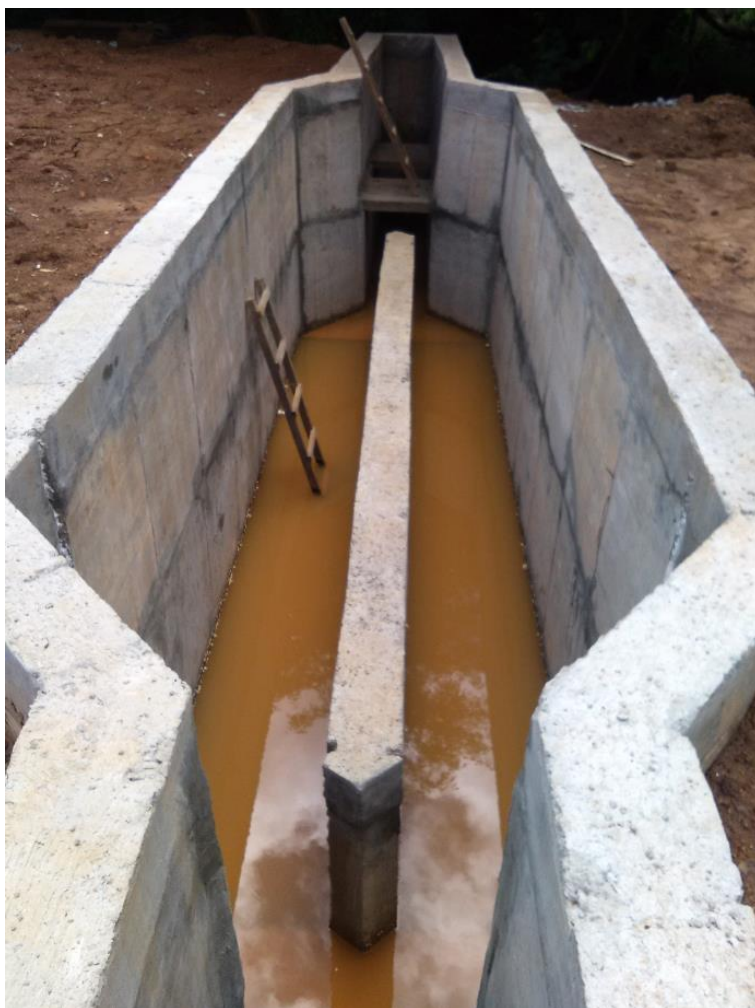
Figura 237 – Foto de modelo de desarenador em construção
