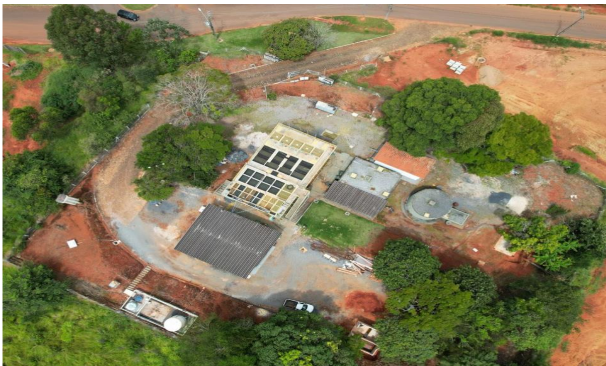
Figura 65 – Vista aérea geral da ETA Campos Altos
