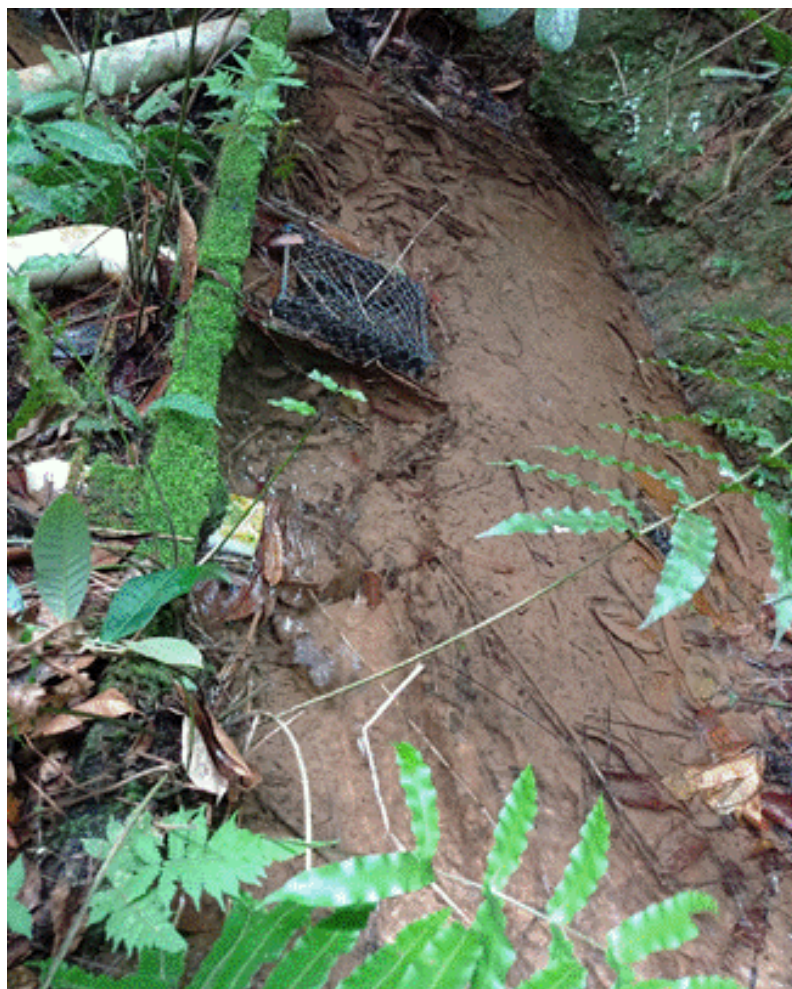
Figura 40 – Barramento em alvenaria na captação de São Jerônimo dos Poções
