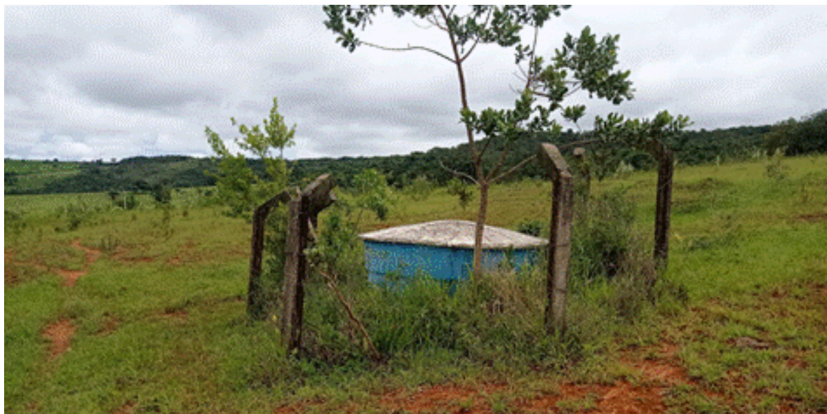
Figura 162 – Reservatório existente de 10m 3
