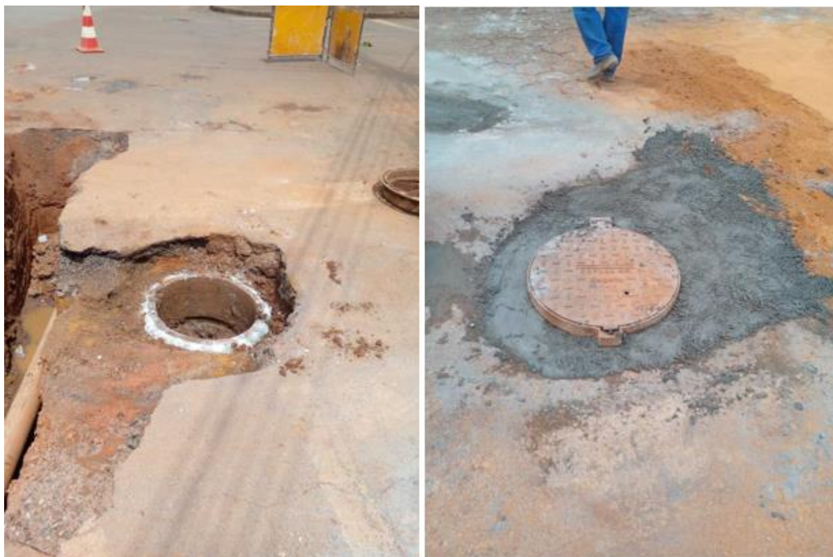
Figura 212 – Exemplo de construção de PV
