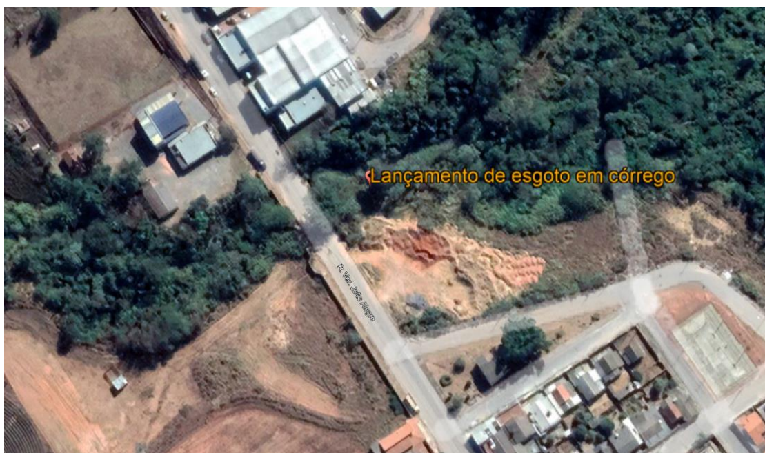
Figura 193 – Indicação do ponto de lançamento de esgoto in natura
