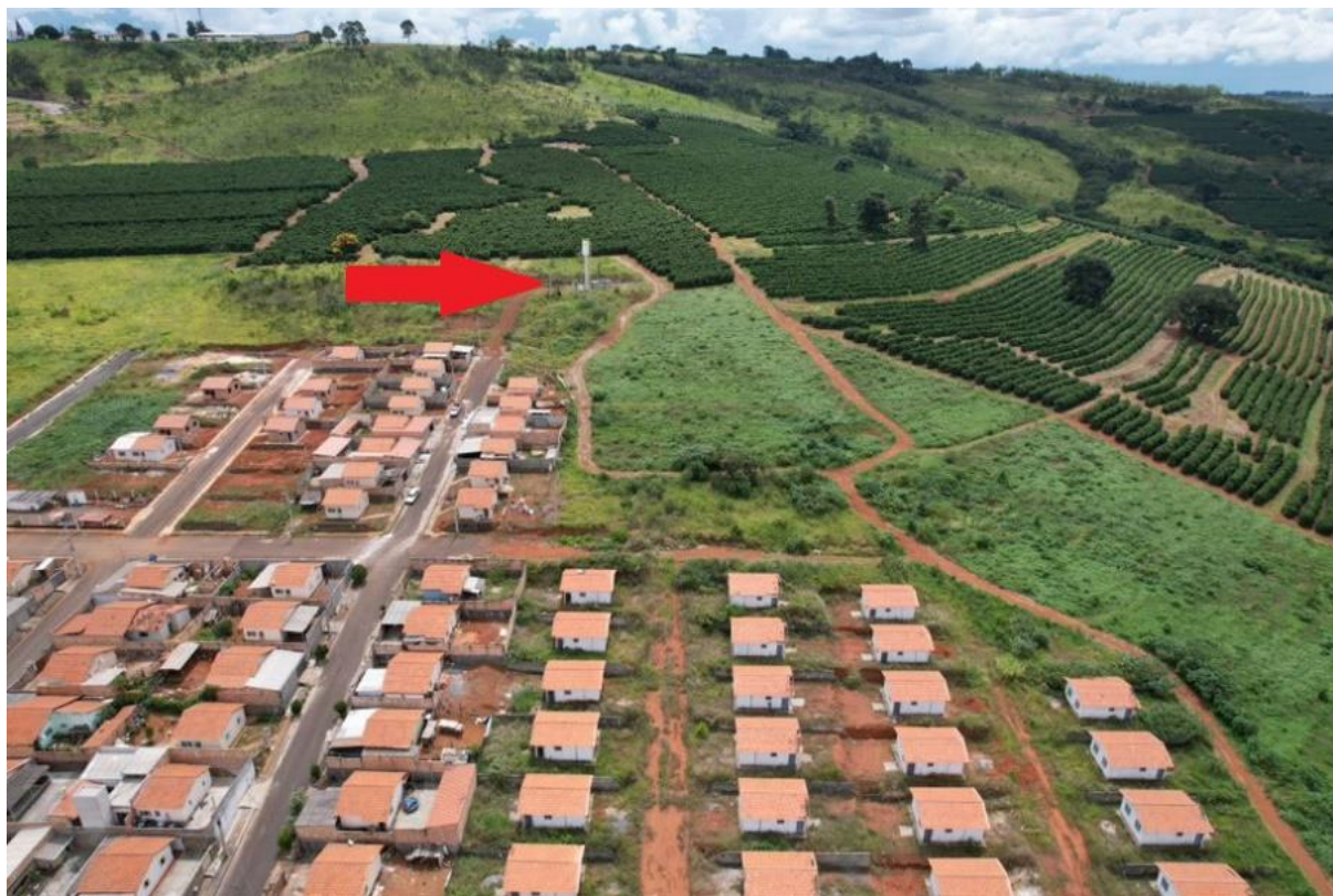
Figura 133 – Localização do RAP06 e REL07, indicados pela seta, e entorno
