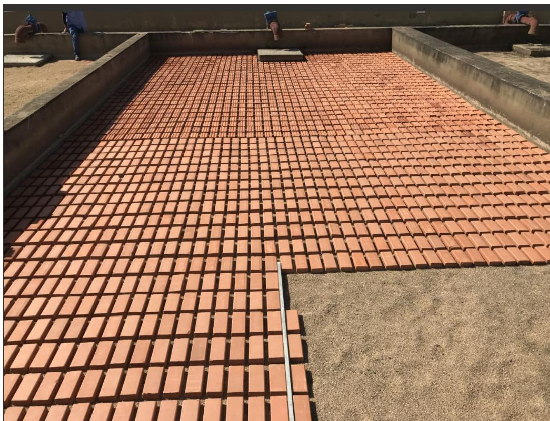
Figura 247 – Leito de secagem similar em execução
