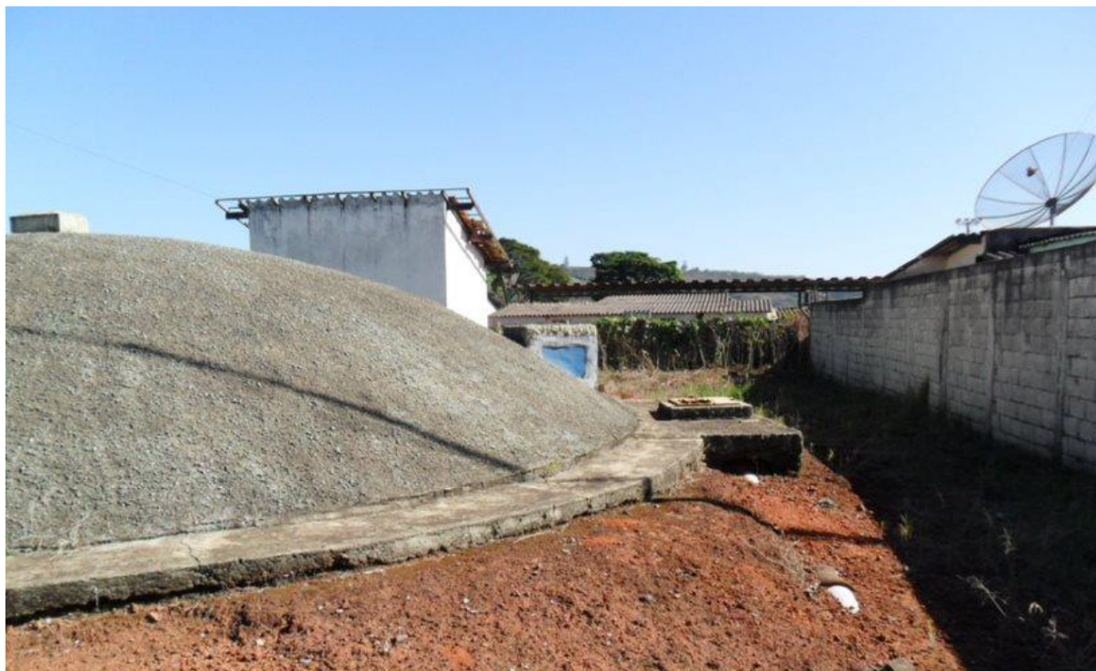
Figura 142 – Vista da área interna do REN 01.
