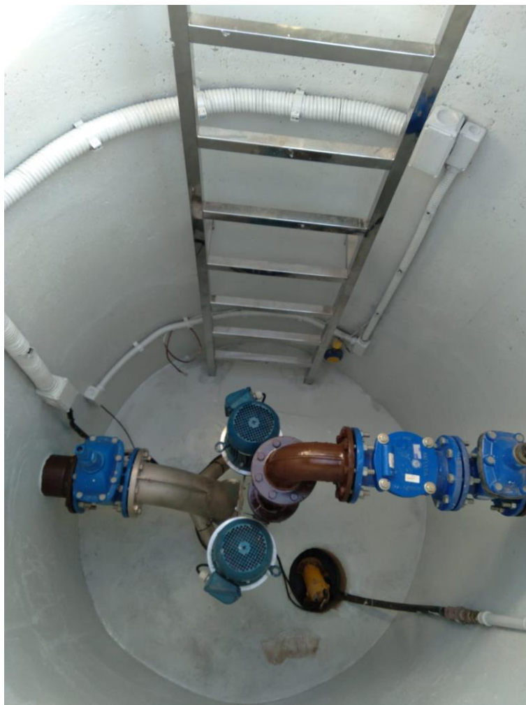
Figura 231 – Parte interna do modelo de SBL a ser implantado
