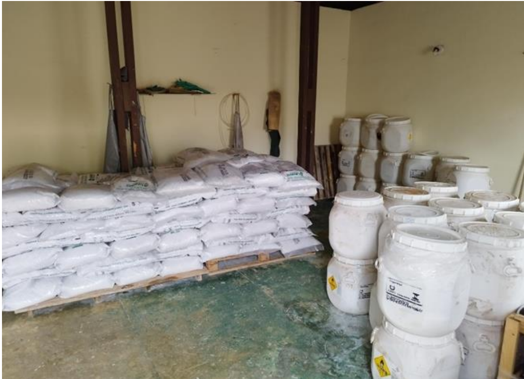
Figura 114 – Depósito produto químico sólido
