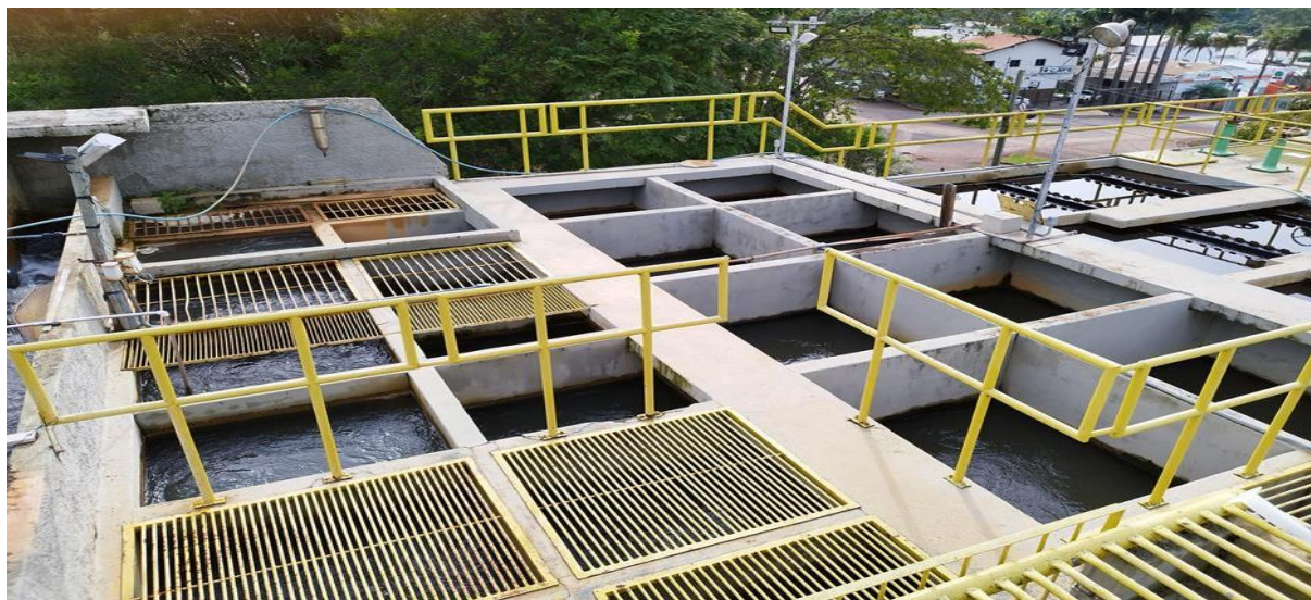
Figura 68 – Vista do floculador
