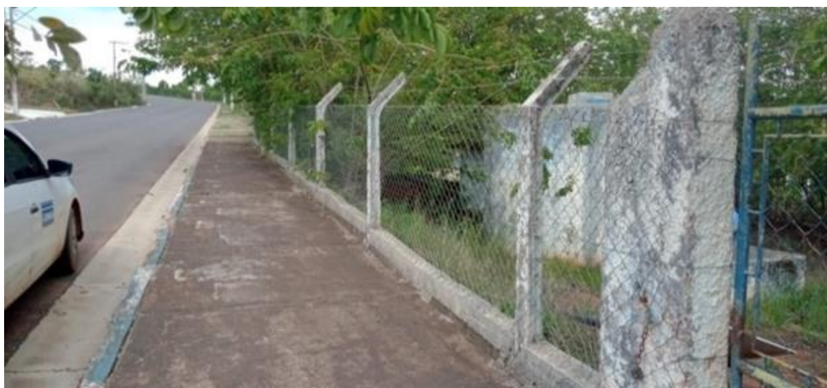
Figura 156 – Cercamento da unidade
