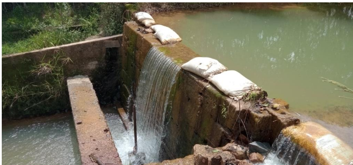
Figura 29 – Barragem de nível do Córrego Engenho da Serra
