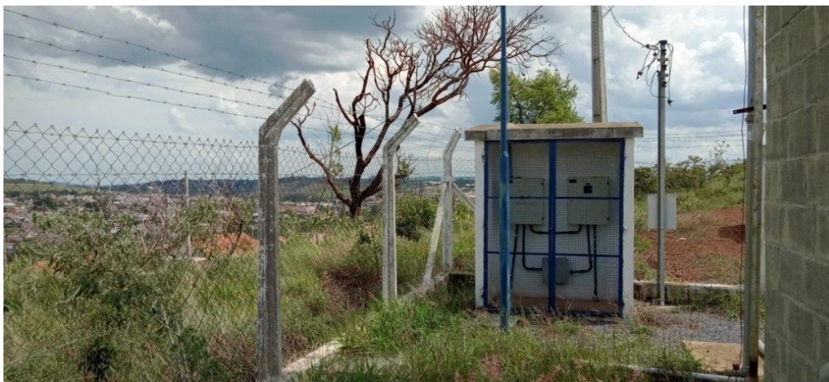
Figura 160 – Cercamento da unidade
