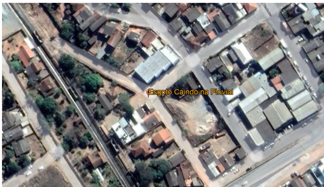
Figura 198 – Lançamento de esgoto na rede pluvial
