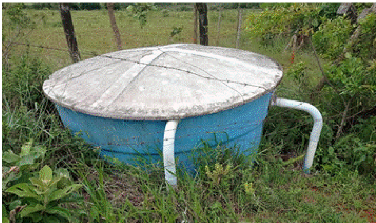
Figura 163 – Reservatório existente de 10 m 3 .
