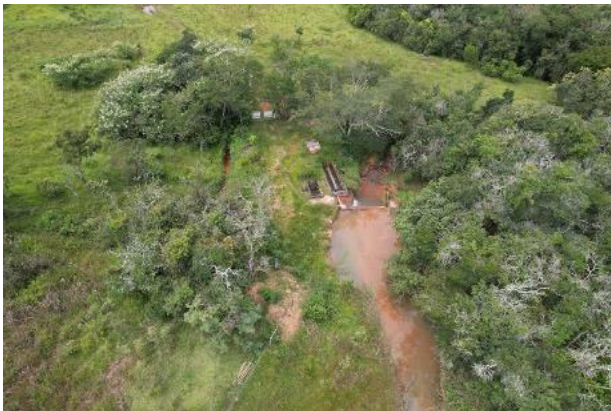
Figura 28 – Vista aérea da Captação do Córrego Engenho da Serra
