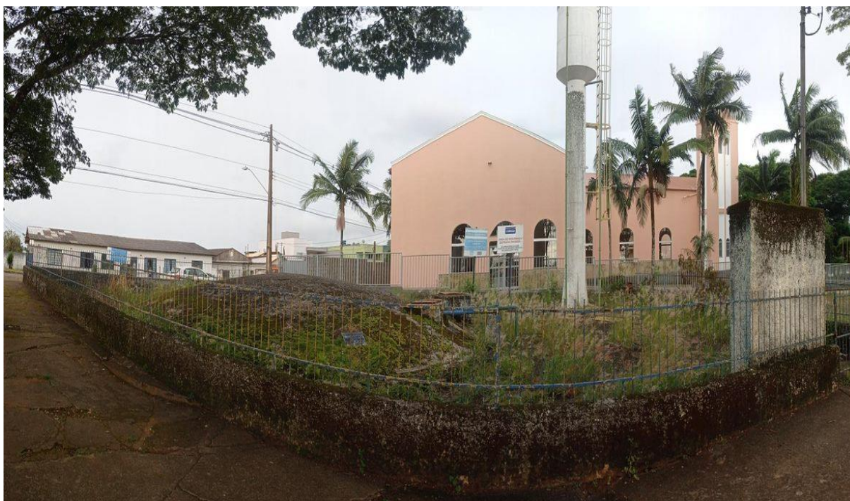
Figura 151– Cercamento da unidade, placa de identificação e advertência
