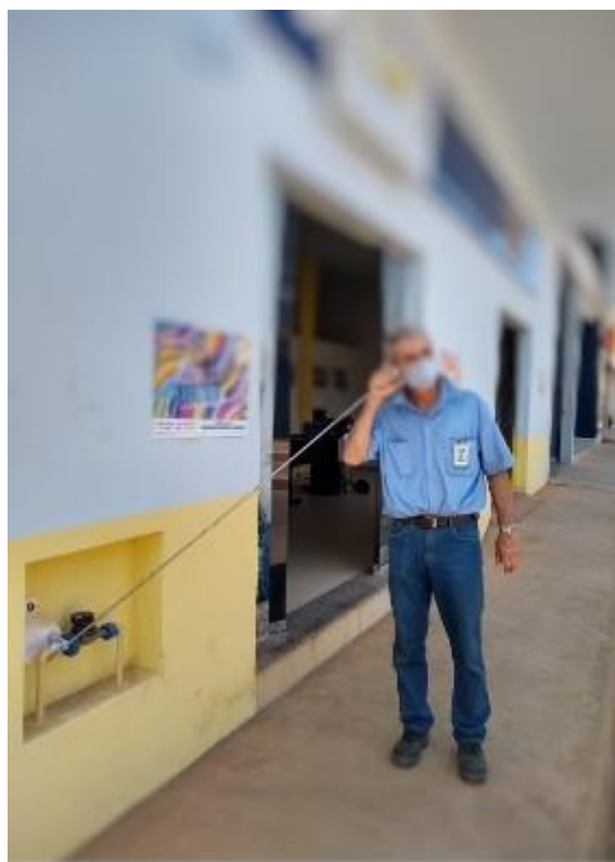
Figura 173 – Pesquisa de vazamento com haste de escuta
