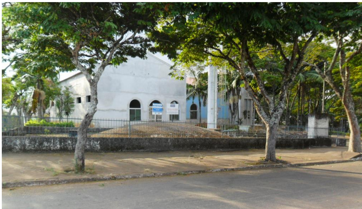
Figura 152 – Cercamento da unidade, placa de identificação e advertência
