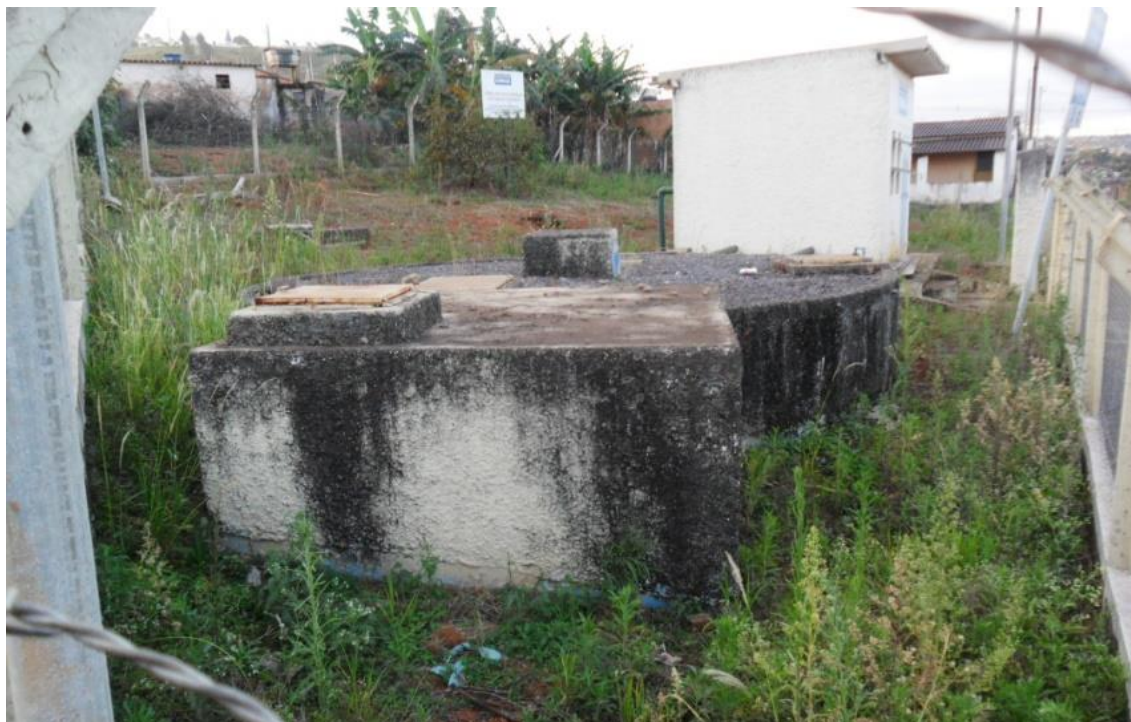
Figura 145 – Cercamento da unidade e placa de identificação
