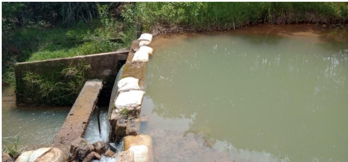
Figura 47 – Barragem do Córrego Engenho da Serra
