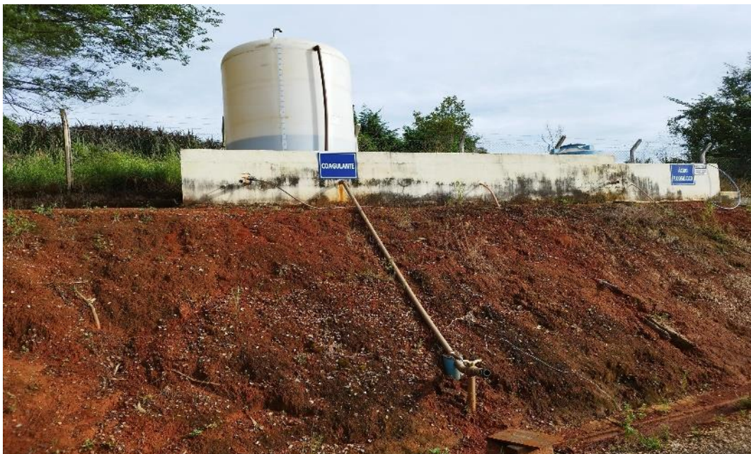
Figura 115 – Depósito produto químico líquido
