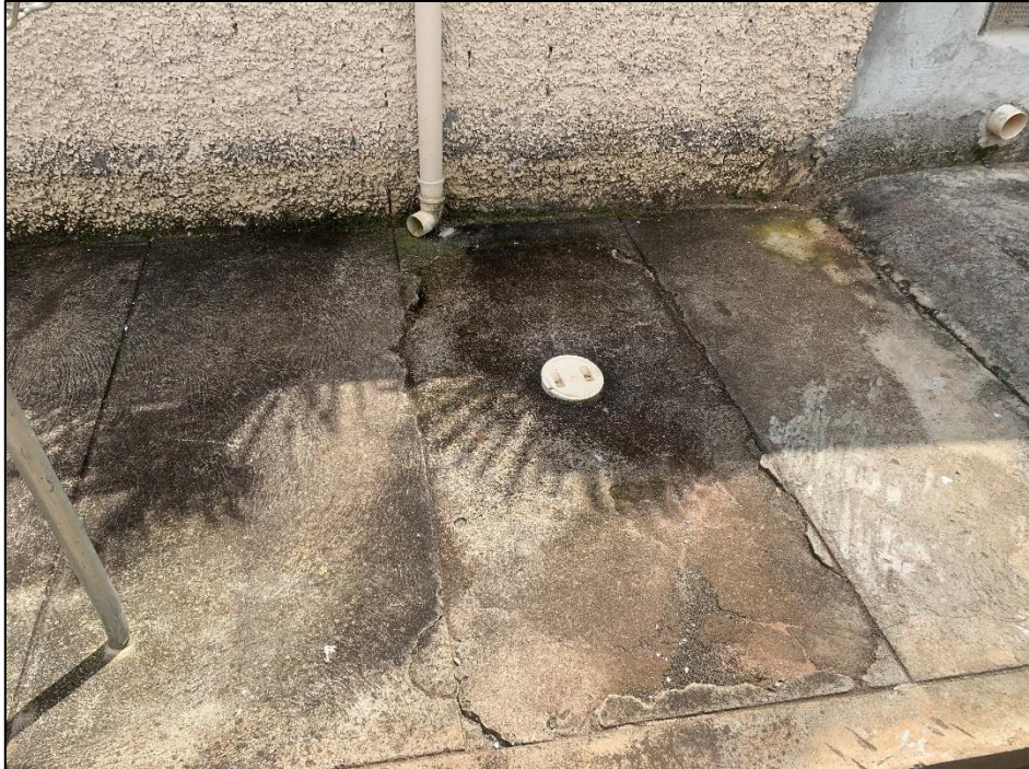
Fossa localizada no bairro Osvaldo Alves de Araújo - Campos Altos
