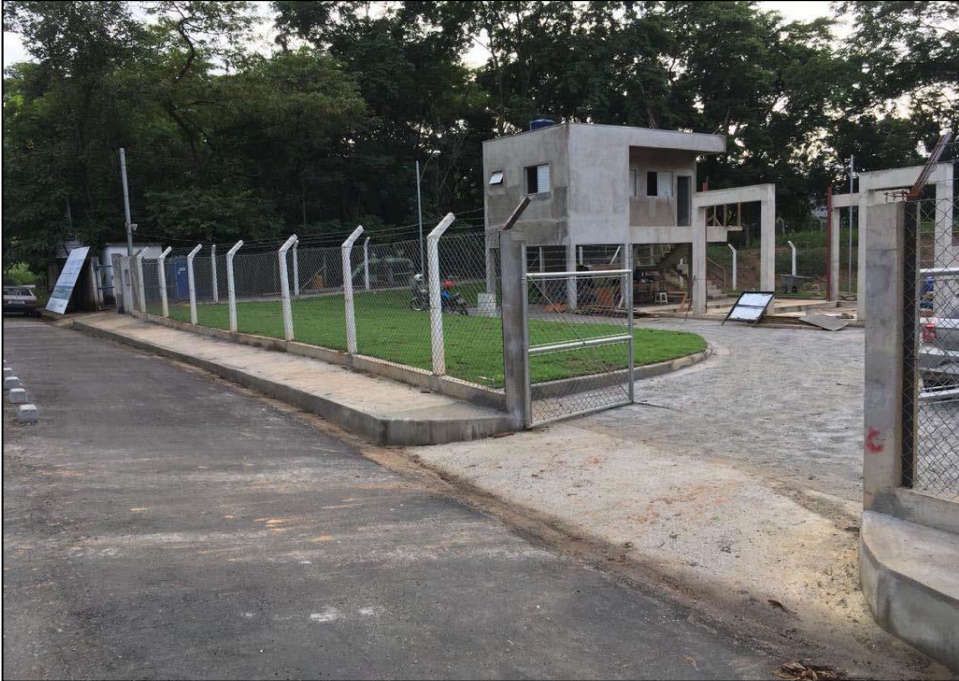
Estação Elevatória de Esgoto em Fase de Acabamento executada pela SOCIENGE
