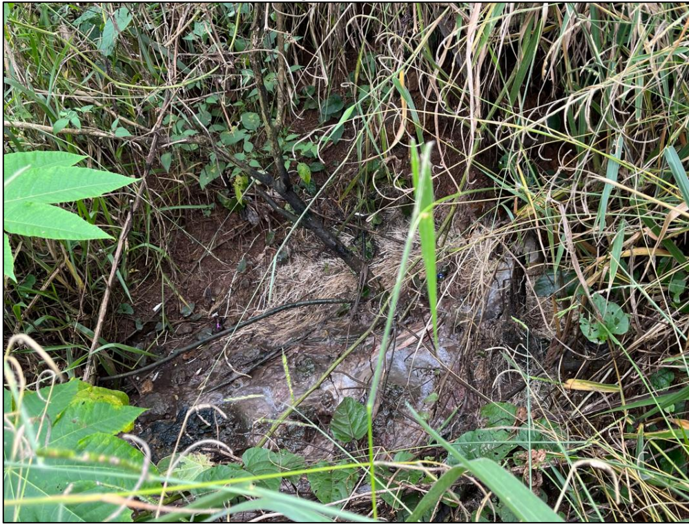
Lançamento de esgoto in natura – Campos Altos
