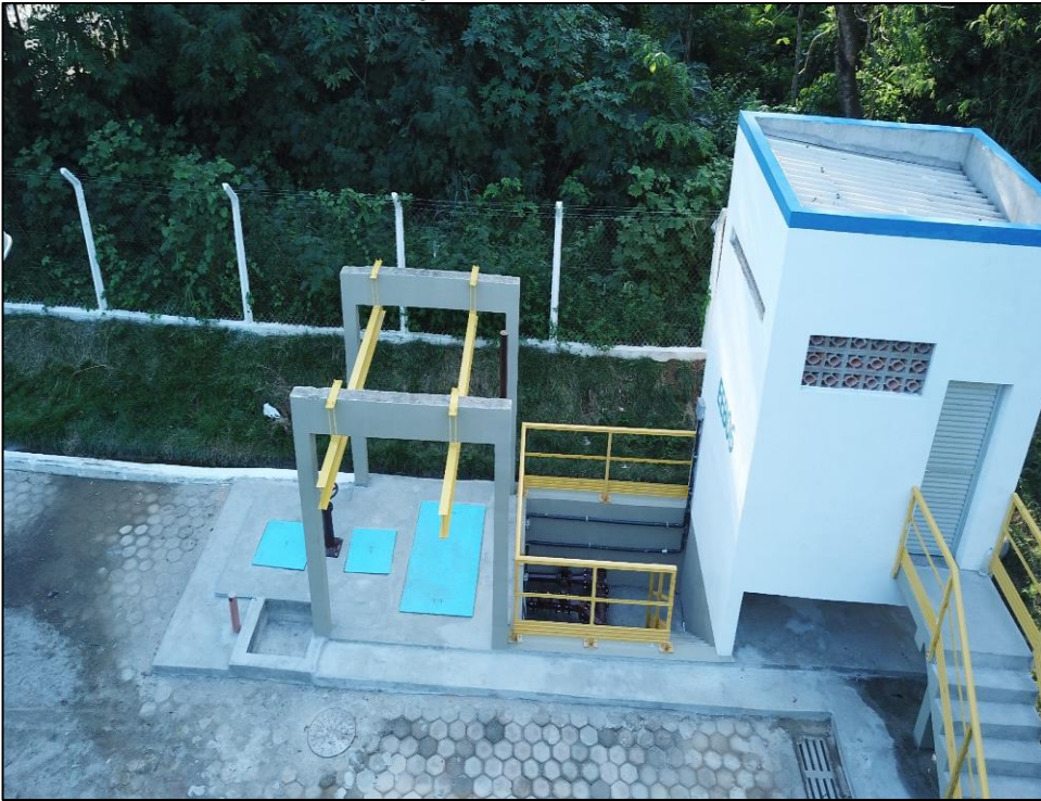
Estação Elevatória de Esgoto Concluída executada pela SOCIENGE
