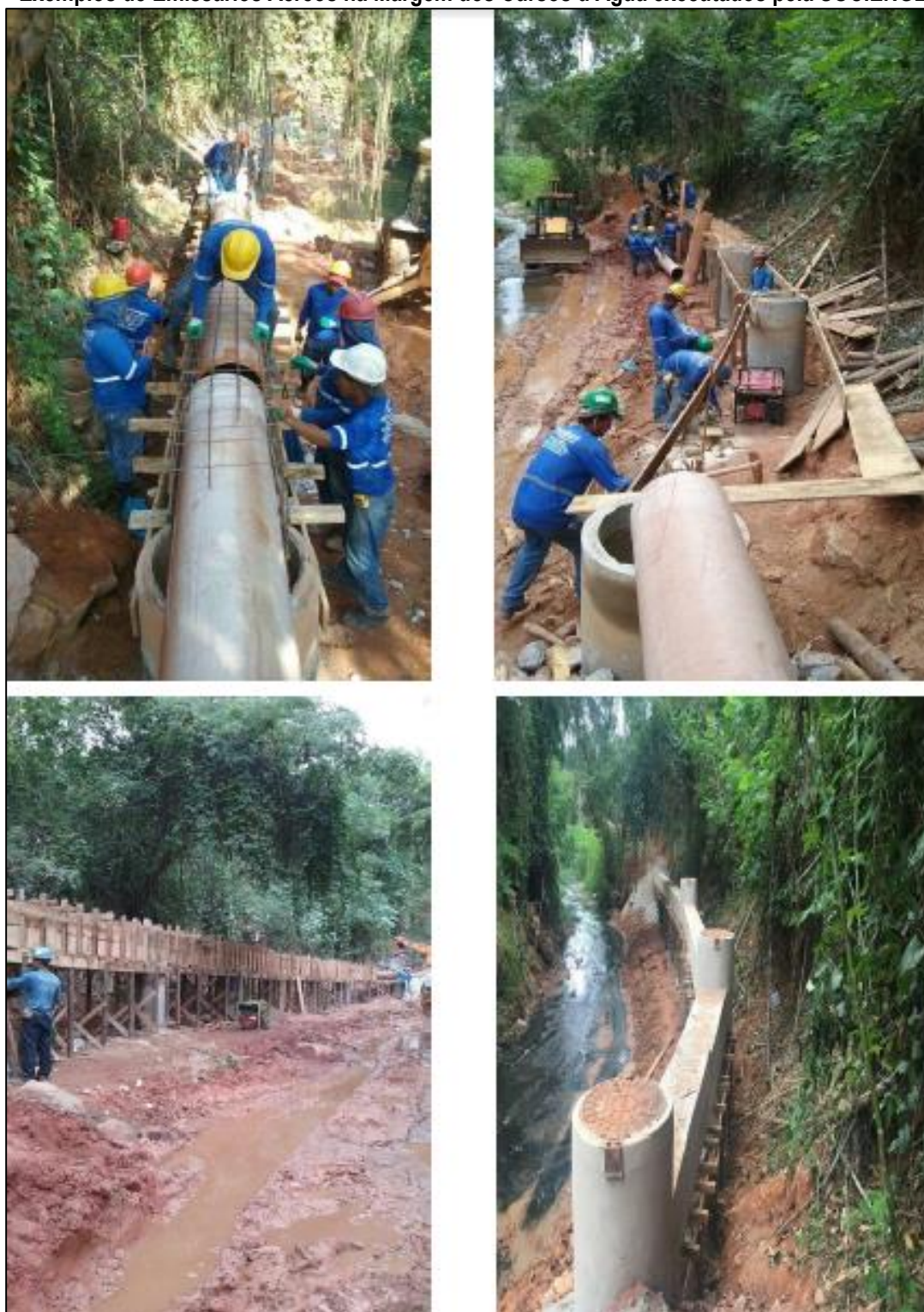
Exemplos de Emissários Aéreos na Margem dos Cursos d'Água executados pela SOCIENGE
