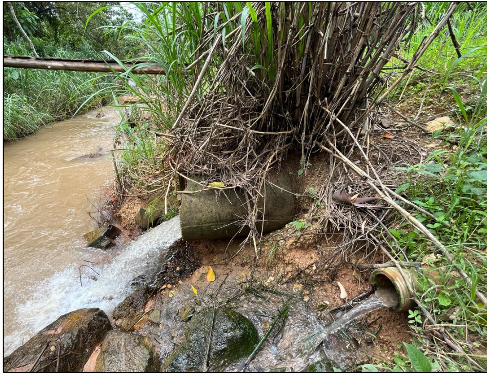
Lançamento de esgoto in natura – Campos Altos
