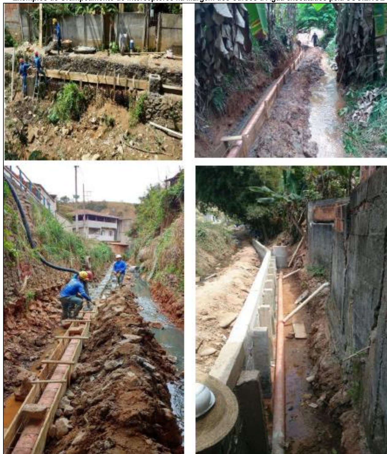
Exemplos de Grampeamento de Interceptores na Margem dos Cursos d'Água executados pela SOCIENGE
