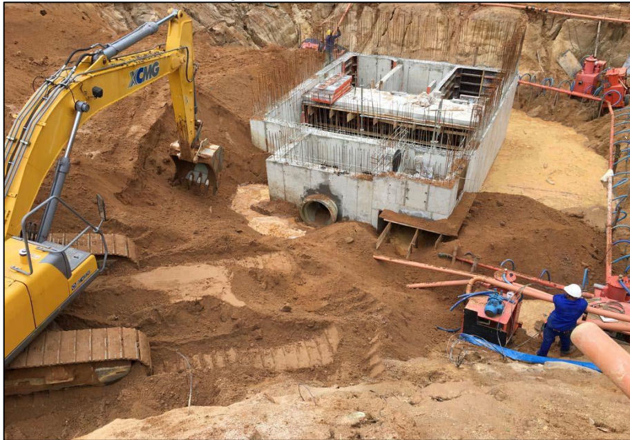
Estação Elevatória de Esgoto em Construção executada pela SOCIENGE
