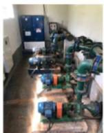
Figura 50: Estações Elevatórias de Água Tratada (EEATs) em bom estado de conservação.
