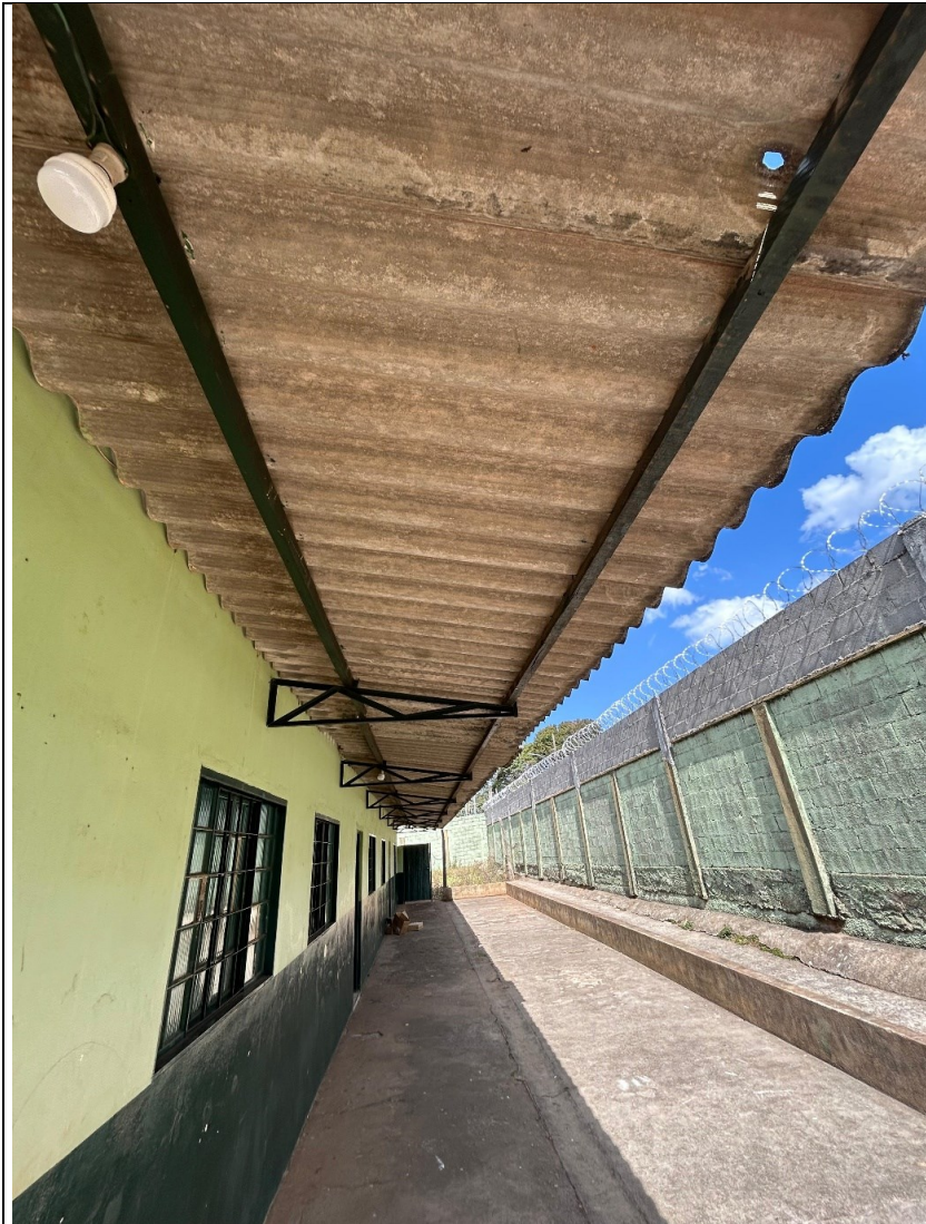
Descrição: COBERTURA SALAS BLOCO 3
