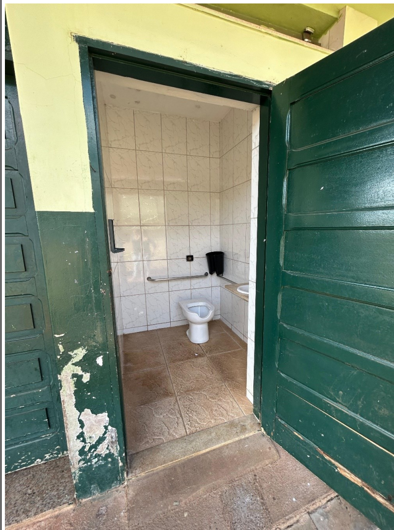
Descrição: BANHEIRO PNE
